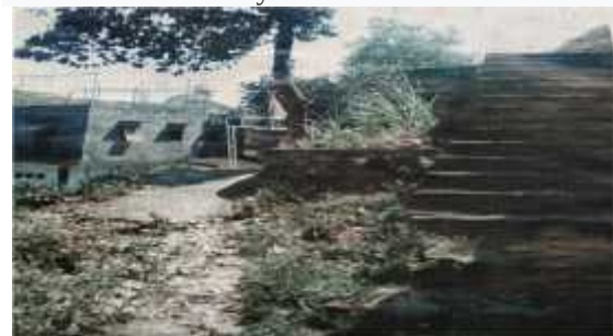
Gambar 3 : Kondisi Jalan Kampung Sebelum Adanya Revitalisasi
