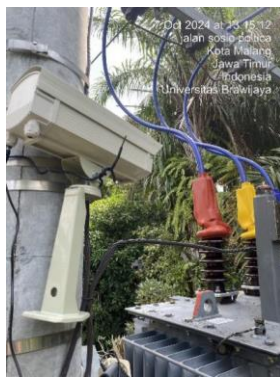
Gambar 3.3 Pemasangan Alat pada Trafo
