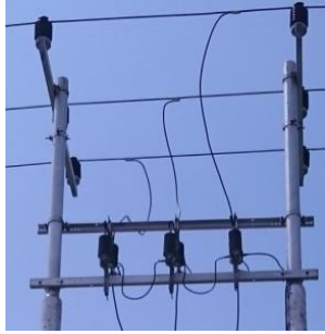
Gambar 2. Konstruksi peletakan arrester pada jaringan distribusi
