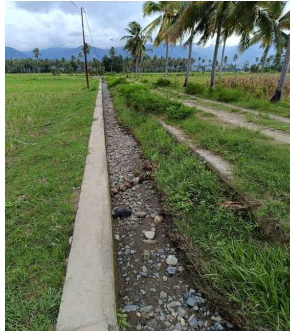
Gambar 8. Kondisi Saluran Ramba Sumber: Dokumentasi Pribadi,2025
