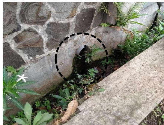
Gambar 4.1: Kondisi Outlet Pembuangan Greywater pada Unit Perumahan.
