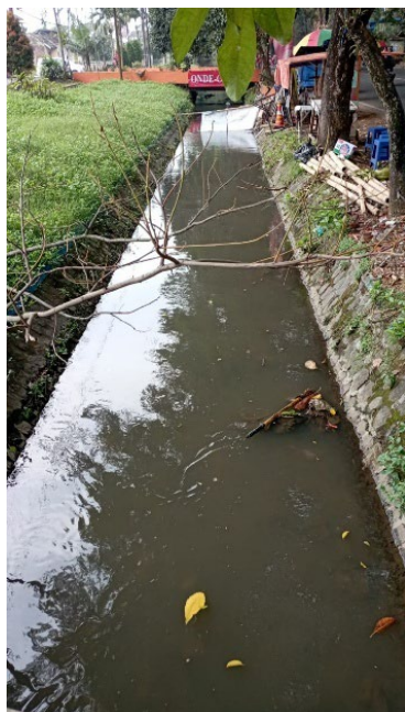
Gambar 2 Foto Saluran Drainase Sebelah Barat Sumber: Dokumentasi Pribadi, 2024
