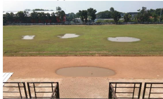
Gambar 1 Kondisi stadion setelah hujan Sumber : Dokumen pribadi, 2025
