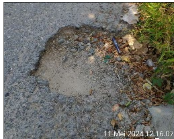
Gambar 7. Survei Kondisi Jalan (Sumber: Dokumentasi Pribadi, 2024)
