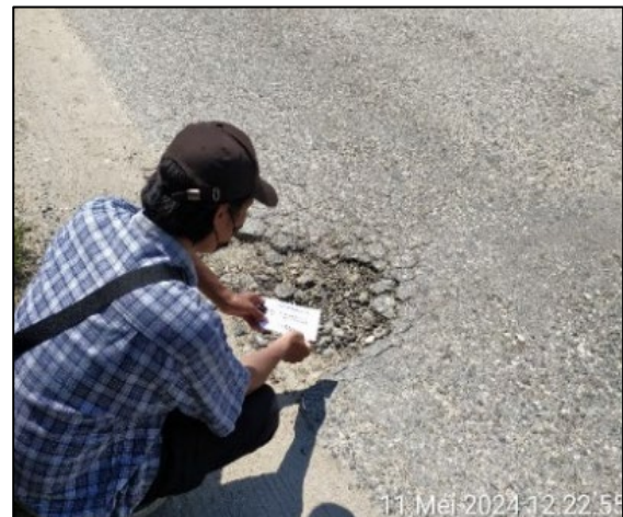
Gambar 6. Survei Kondisi Jalan (Sumber: Dokumentasi Pribadi, 2024)
