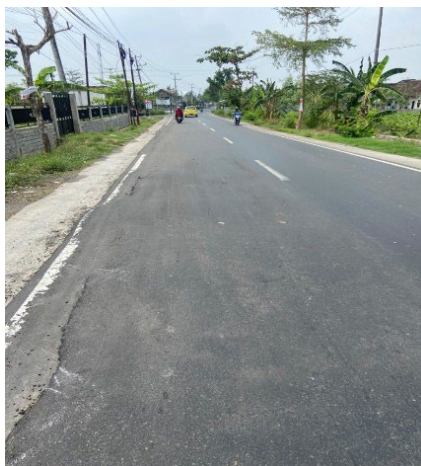
Gambar 3. Lubang STA 0+000 Sumber : Dokumentasi Pribadi (2024)
