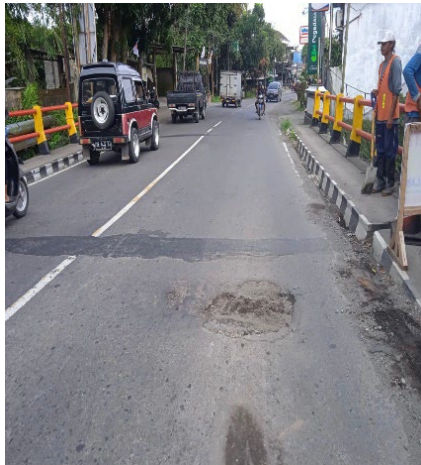
Gambar 2. Lubang STA 0+000 Sumber : Dokumentasi Pribadi (2024)
