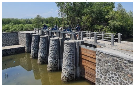
Gambar 2 Lokasi Penelitian Pintu Air Desa Kalibuntu, Kecamatan Kraksaan, Kabupaten Probolinggo
