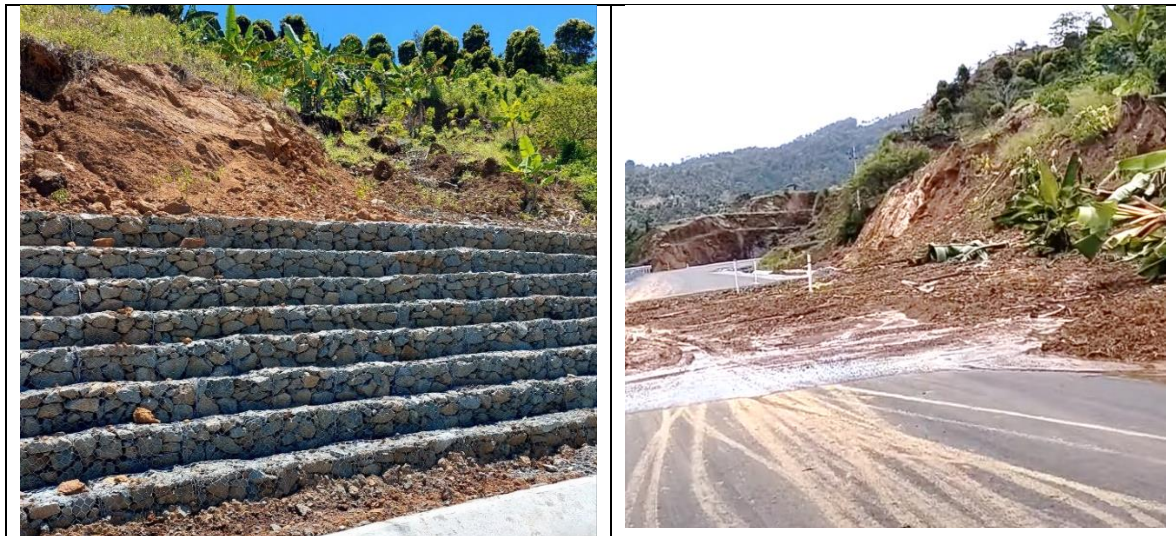
Gambar 2 Kondisi Lereng Eksisting dan longsoran titik tertentu Sumber : (Dokumentasi Pribadi, 2023).
