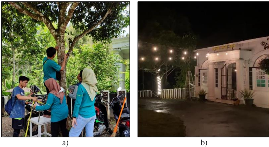
Gambar 3. a) Pemasangan lampu LED strip di area cafe. b) Hasil jadi lampu LED strip yang dipasang di area cafe Dilem Wilis
